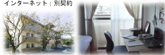
国際交流会館の外観と室内
